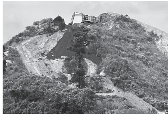
崩落被害防止のため高さ低減作業を実施中
