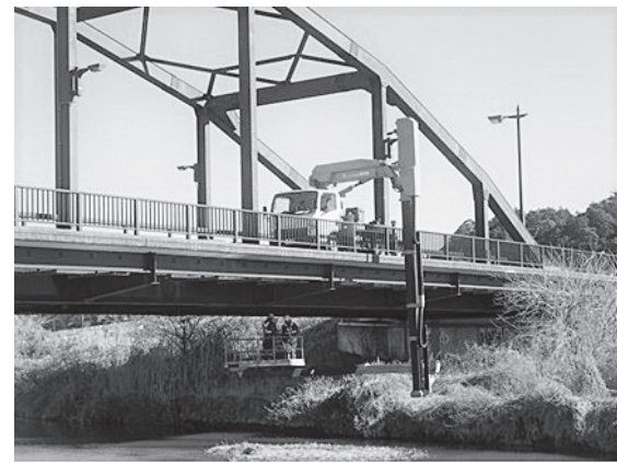
橋の安全を支える点検
