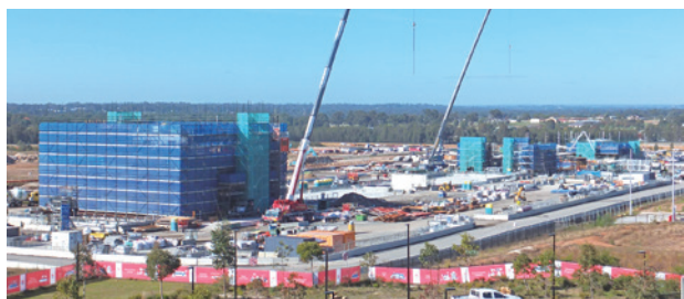
空港開港に向け進む鉄道駅の整備
