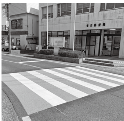
カラー塗装された横断歩道
