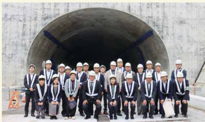
完成間近の芝山トンネル
