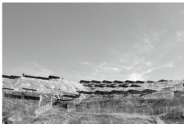
町で指導中の太陽光パネル設置状況
