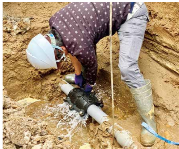
老朽化した水道施設の更新
