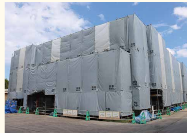
令和8年1月完成予定の学童保育所
