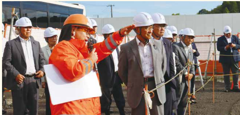
工事現場の進捗状況を確認
