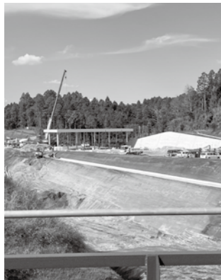
工事が進む圏央道多古IC周辺
