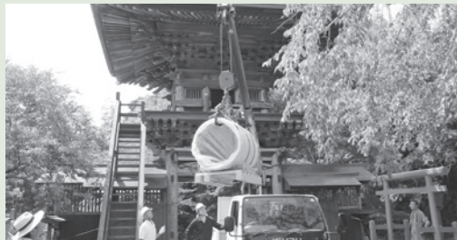
暑い中に行われた設置作業
