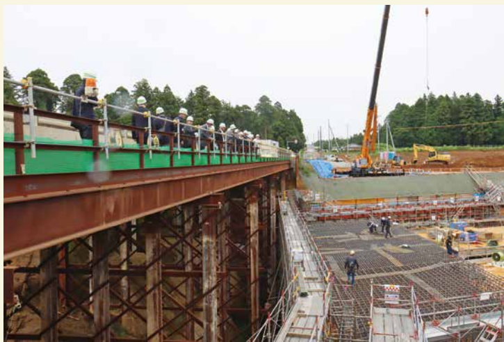
圏央道多古 IC の工事現場を視察する議員たち
