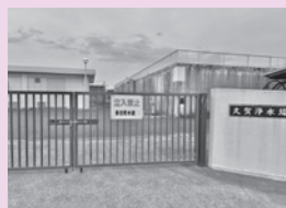
現在の久賀浄水場
