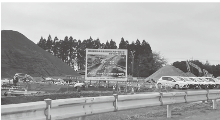
整備が進む圏央道の(仮称)国道296号インターチェンジ
