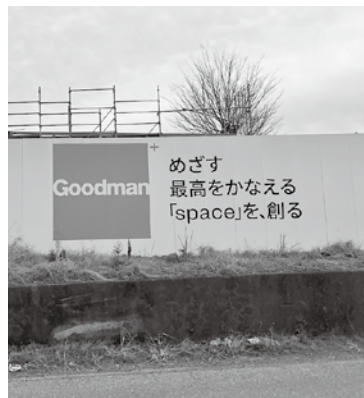
当該地区で建設中のグッドマンの事務所
