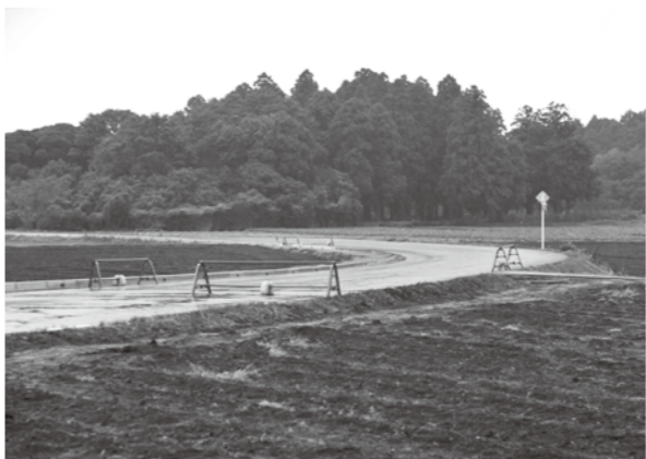
改良工事が進む南玉造線
