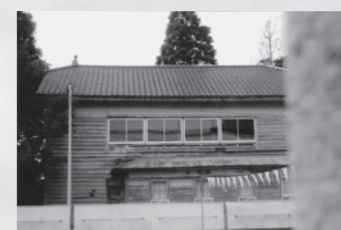
職員室として使用していた建物
