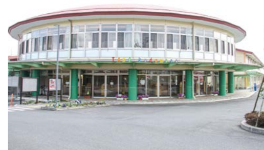
増築工事が予定されるこども園
