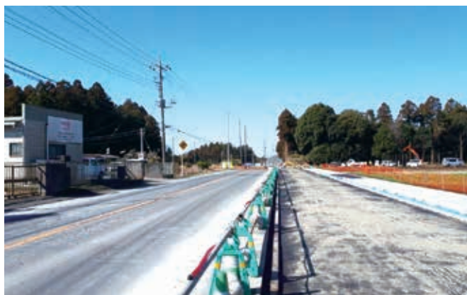
工事が進む国道296号4車線化
