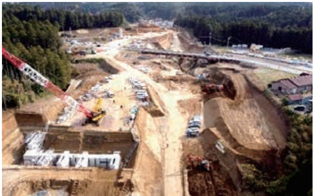
建設がすすむ圏央道 多古インターチェンジ
