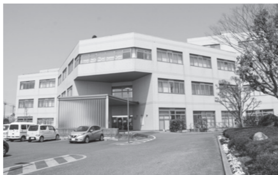
病床の転換が行われる西病棟
