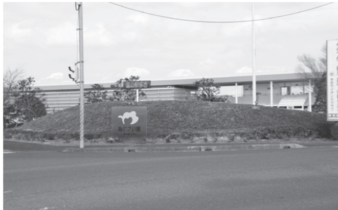
駐車場改修のため工事される築山
