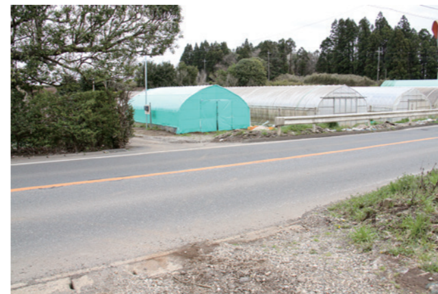
設計等が始まる町道の起点周辺
