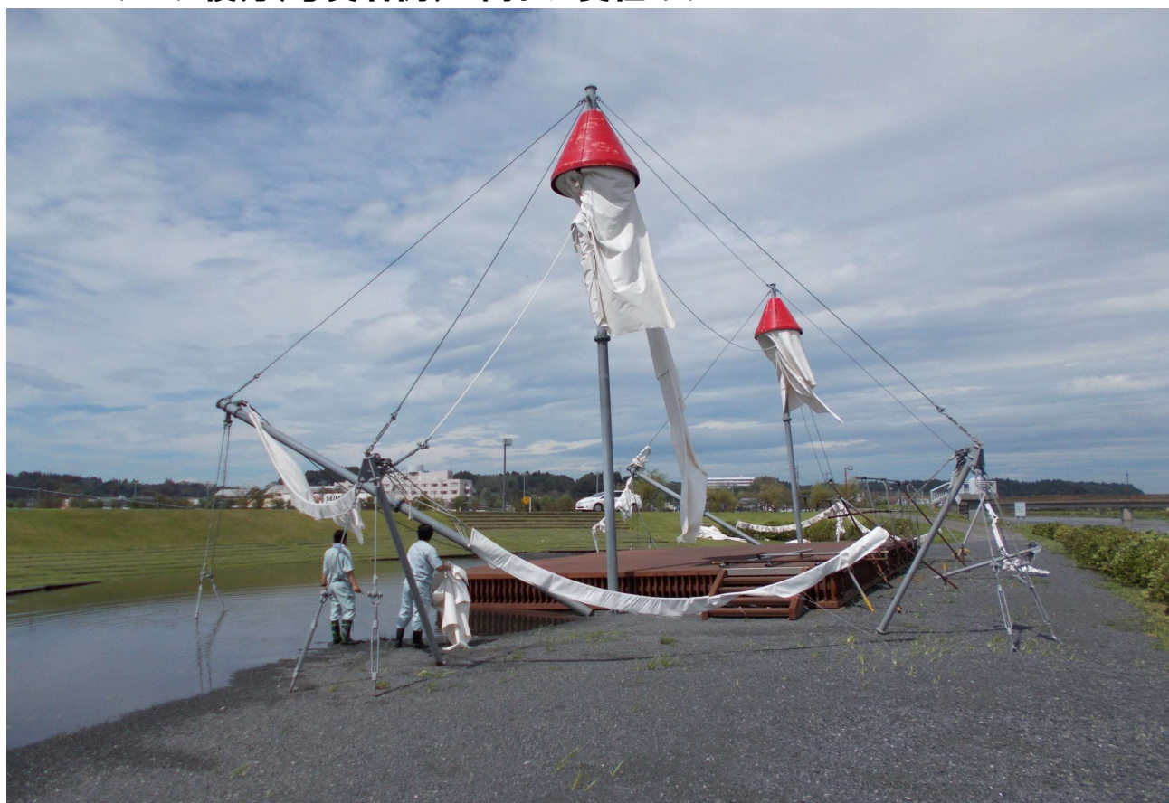
⑥破損後(ステージ上手側後方より撮影) ※ステージ後方(写真右側)に倒れた支柱あり
