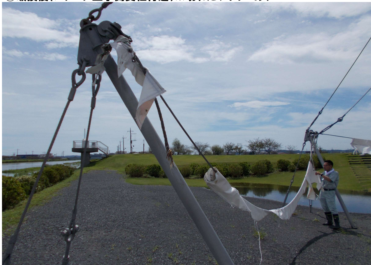
⑧破損後(ステージ上手側支柱付近)※切れたワイヤーあり
