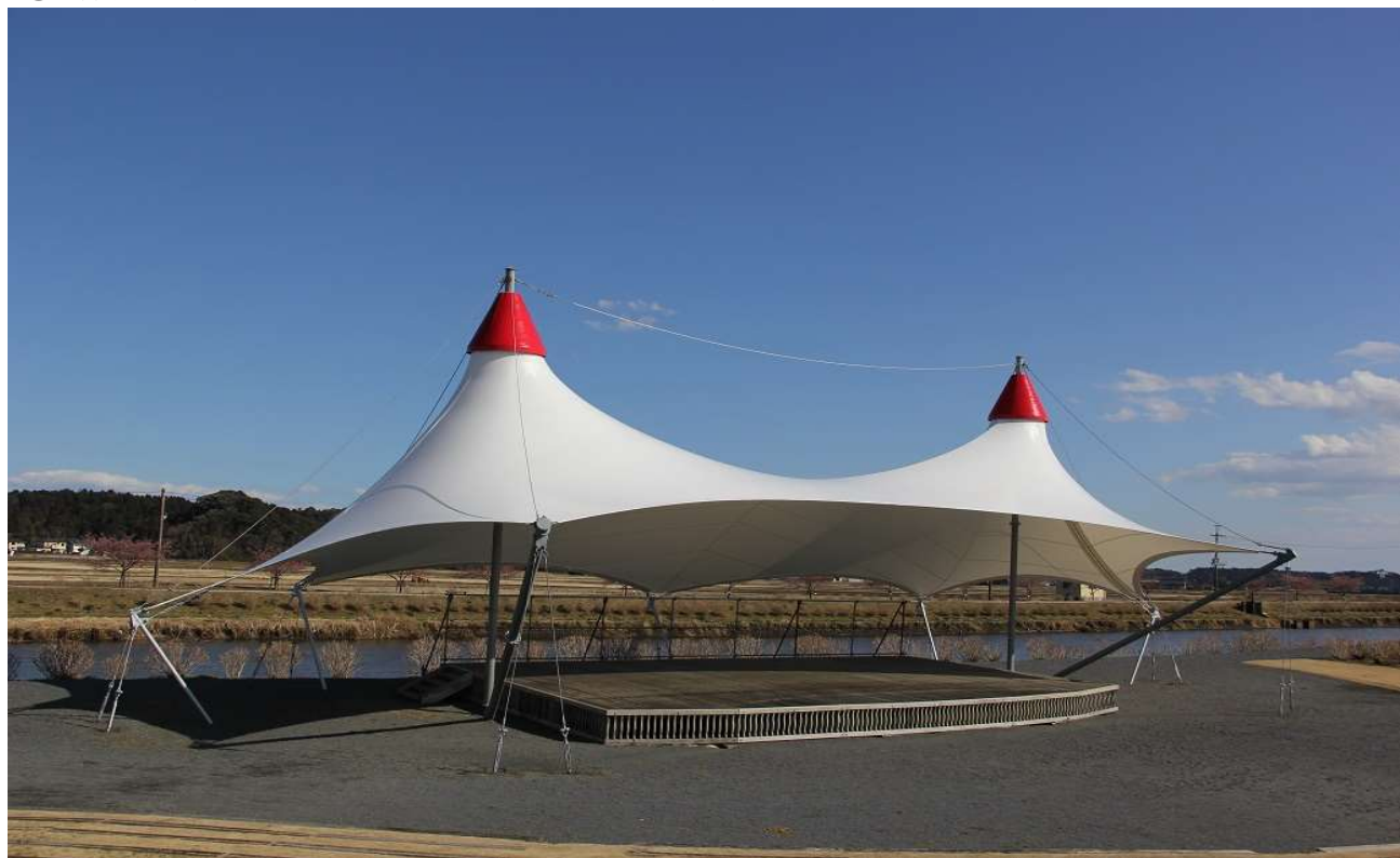
③破損前(ステージ下手側前方より撮影)
