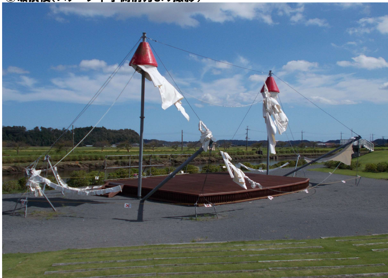
⑤破損後(ステージ下手側前方より撮影)
