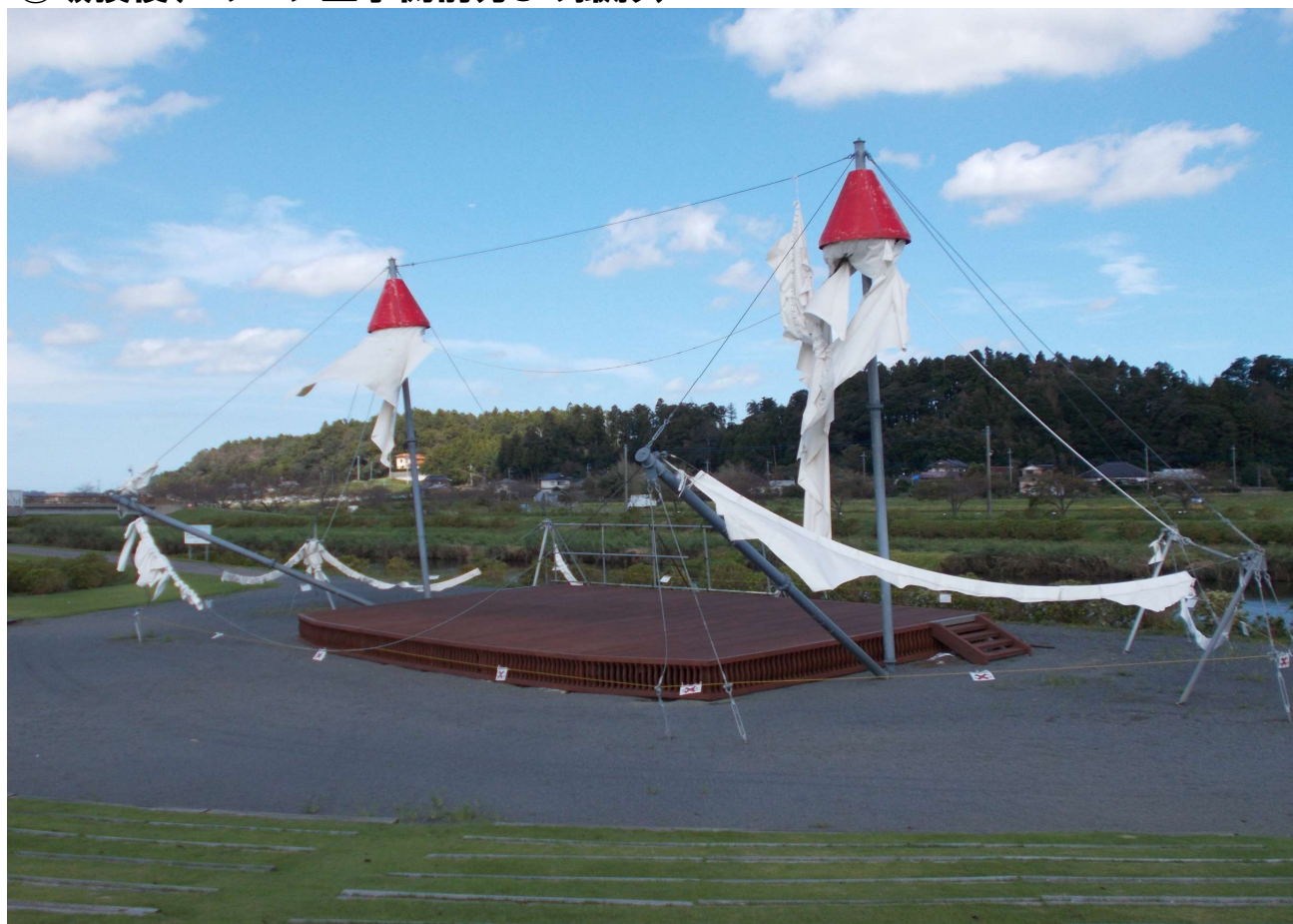
④破損後(ステージ上手側前方より撮影)
