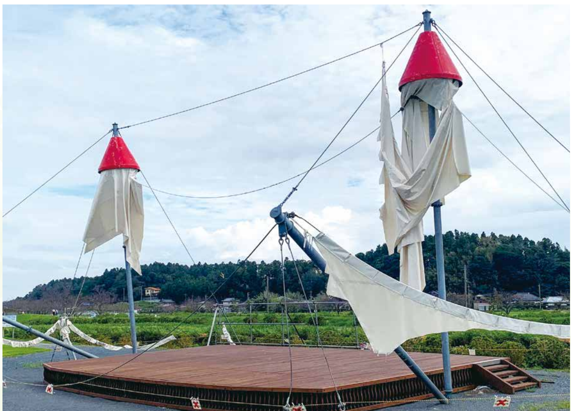
復旧工事費が補正されたレインボーステージ
