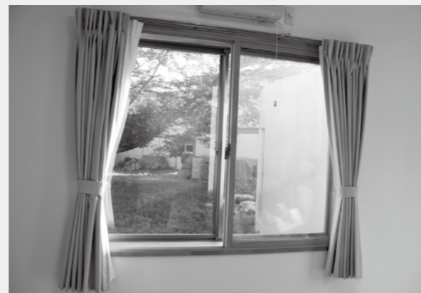
内窓を施した二重窓
