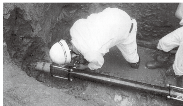
水道管のとりつけ作業の様子
