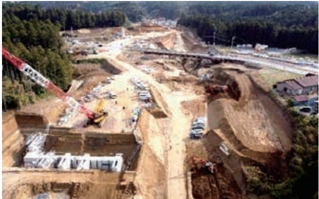
建設がすすむ圏央道 多古インターチェンジ 提供：NEXCO 東日本 千葉工事事務所
