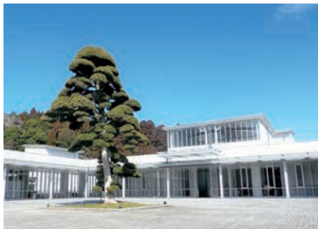
匝瑳市ほか二町環境衛生組合 山桑メモリアルホール
