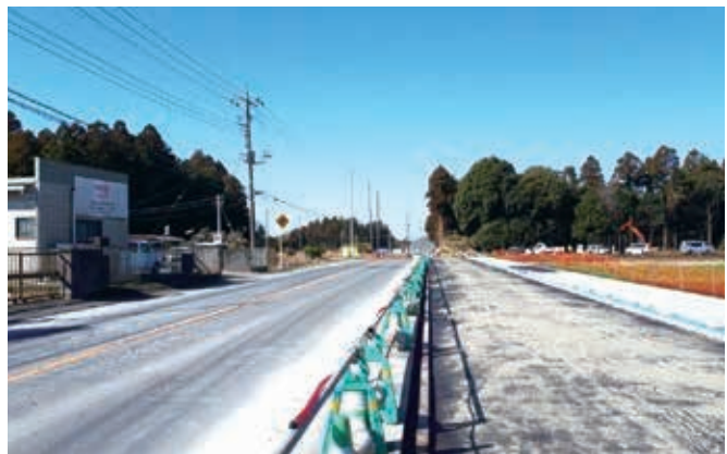
工事が進む国道296号4車線化
