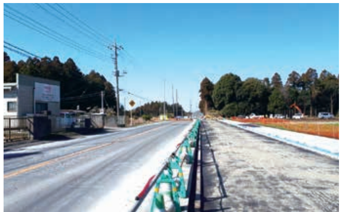
工事が進む国道296号4車線化
