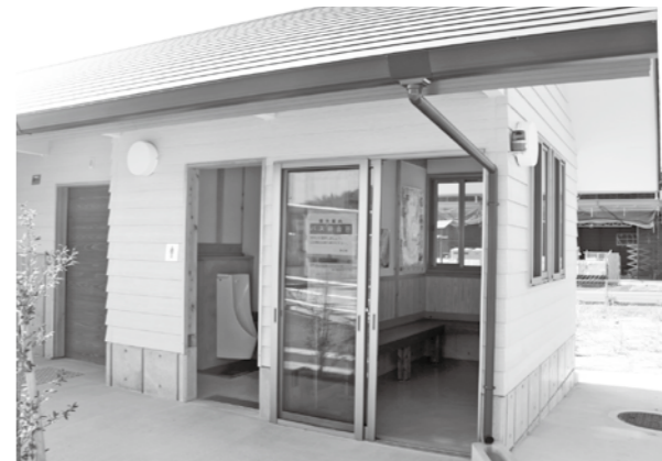
現在はポスター、パンフレットが設置されている待合室
