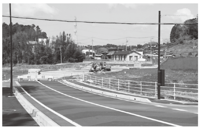
完成間近の町道染井・多古台線
