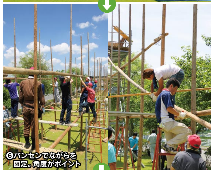
⑤両側で計52本もの ながらが立てられる
