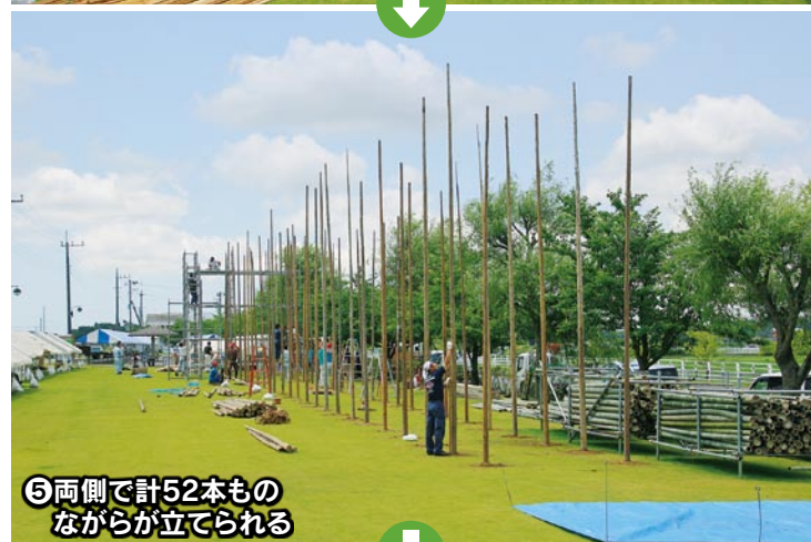
④足場を組んで乗車場作り
