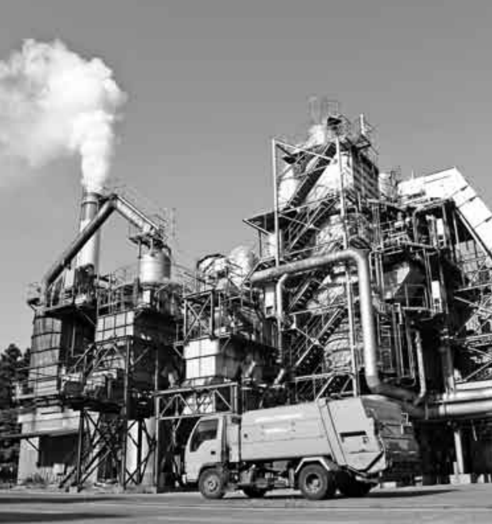
年未年始以外、毎日16時間ごみを処理し続ける焼却炉。1日に44tものごみを焼却する
