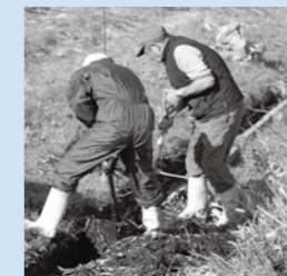
(左) 側溝に詰まった泥を取り除き、使えるようにします
