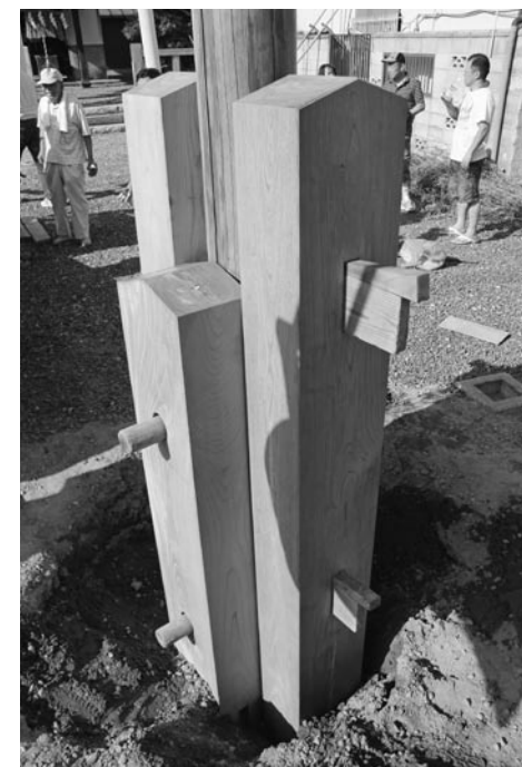
新しい柱で支えられる「つくめ柱」
