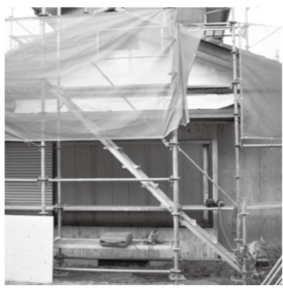
耐震改修の様子
