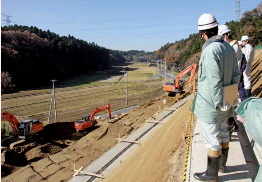
町道飯笹・西古内線（通称）1000m カーブ工事現場の切土を視察
