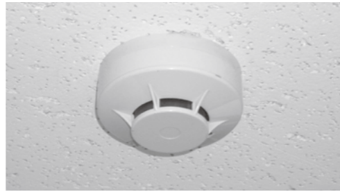
平成20年6月から設置が義務化された住宅用火災警報器
