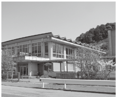
耐震診断中の牛尾体育館
