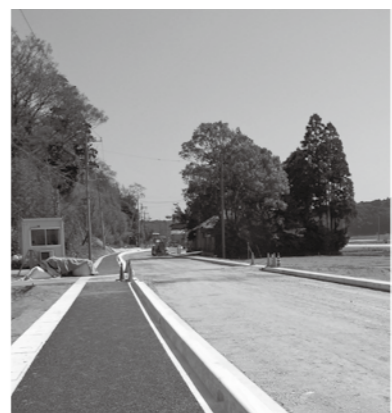
整備が進む町道飯笹・西古内線
