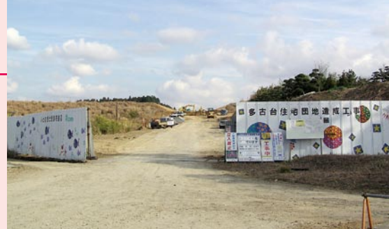
道路工事が進む多古台住宅団地跡地 (国道296号線より)
