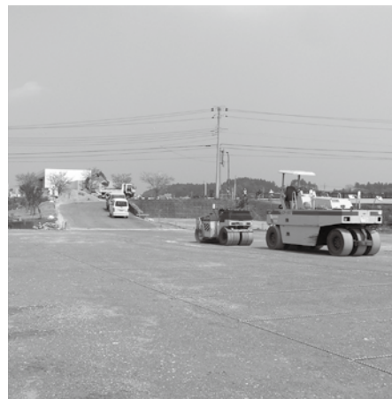
完成間近の道の駅多古駐車場
