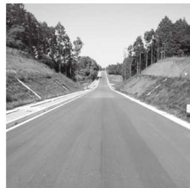
年度内に完成予定の町道飯笹・西古内線
