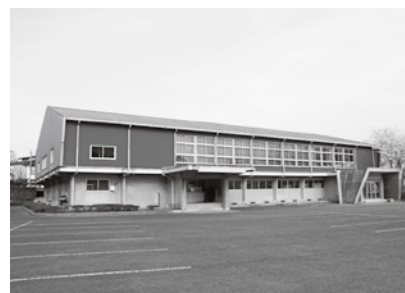
老朽化の進む町民体育館
