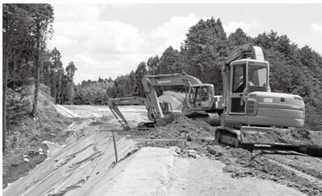
町道飯笹・西古内線（終点の飯笹口交差点付近工事現場）
